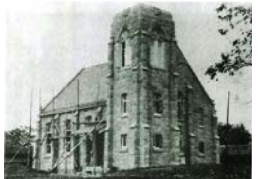
安中教会 (1919年 建設中の写真)
